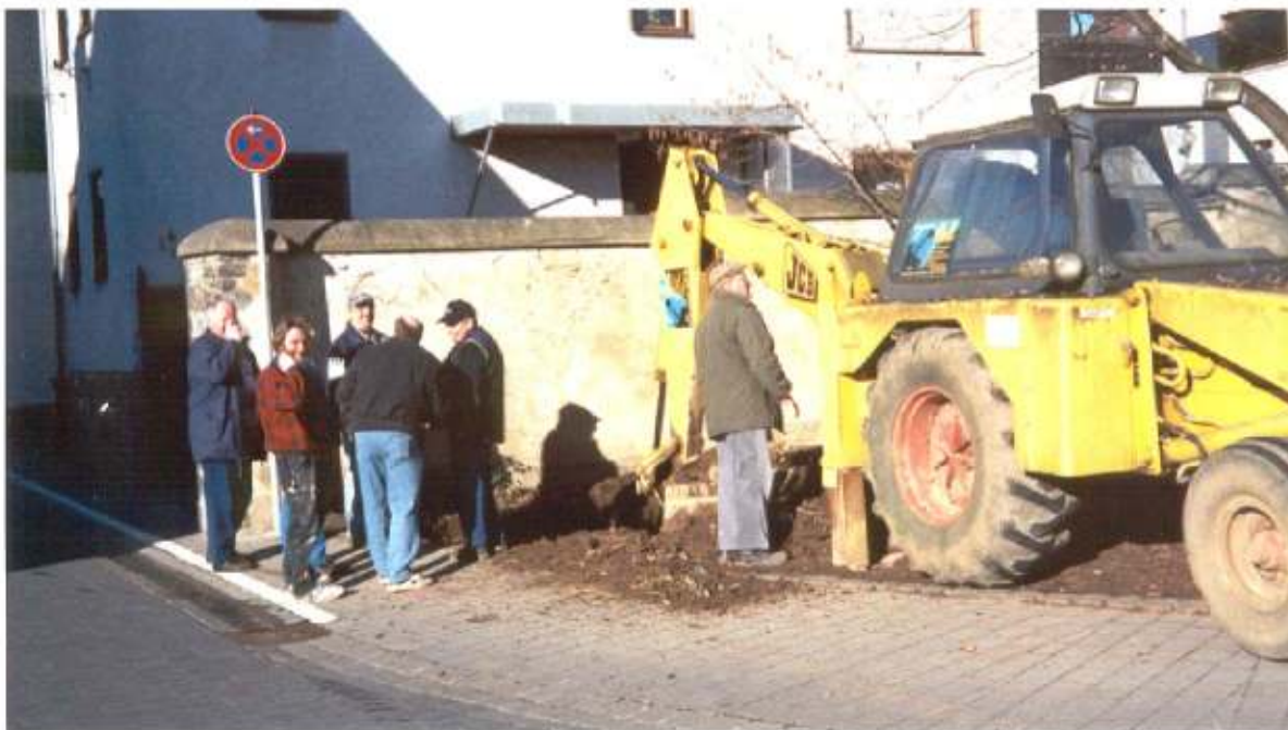
Mit den Erdarbeiten wurde begonnen !
