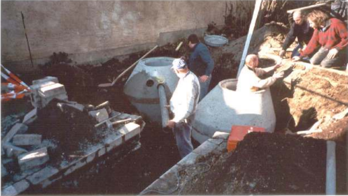
Am 16.02.2002 waren die Tiefbauarbeiten in vollem Gange !
