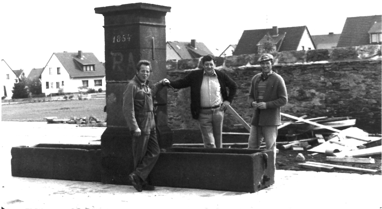
Von links nach rechts Hans Probstfeld von der Fa. Berens, Leo Nell Bürgermeister von Polch und Viedel und Hans Weber. Bei Arbeiten im Freizeitpark Polch um 1979
