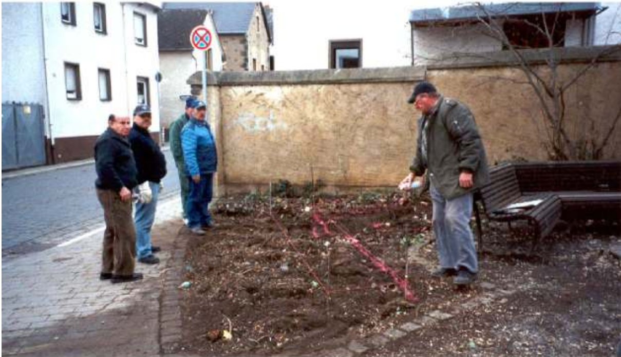
Am 26.01.2002 wurde unter strenger Kontrolle alles für den Erdaushub vorbereitet !
